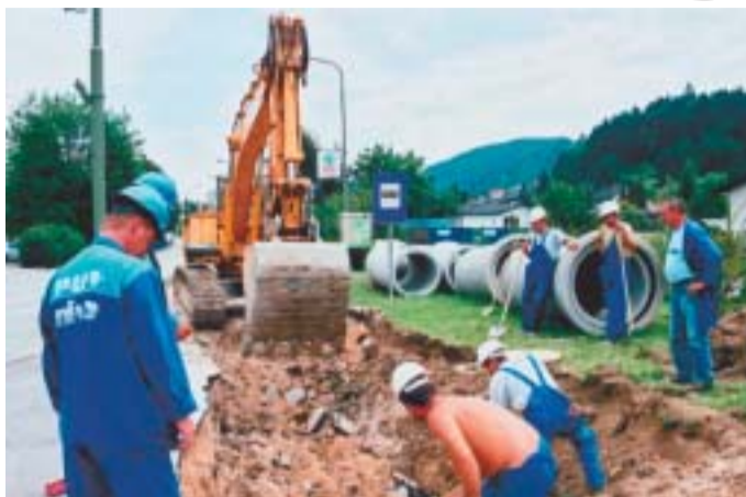
Prve lopate so zasadili oprezno, potem ko je svoje opravila preizkušena gradbena tehnika.
