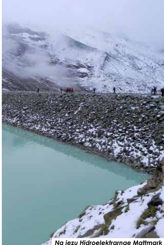
Na jezu Hidroelektrarne Mattmark
